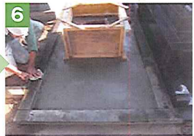
6 コンクリート打設
