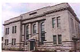
第四銀行住吉町支店 復元工事
